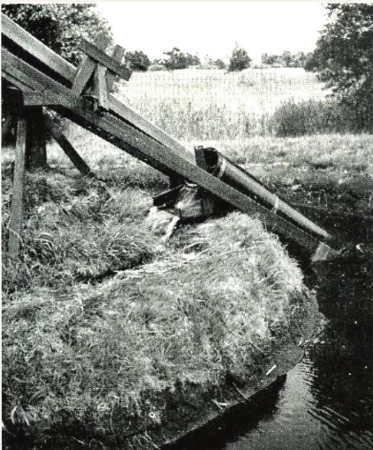
4. De werkende tonmolen van de tjasker te Kalenberg (Ov.)
